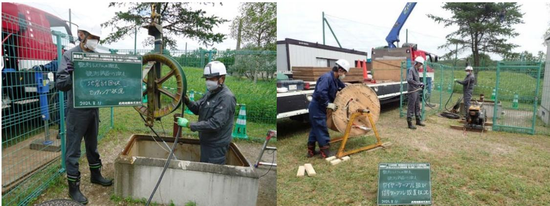
図 4.2-18 孔内地震計回収準備
