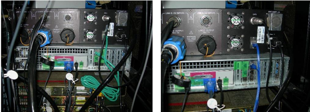
図 4.3-8 イーサネットケーブル交換およびポート変更
