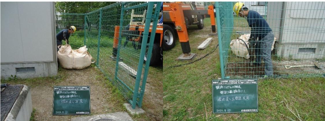
図 4.2-23 埋め戻しおよび整地作業
