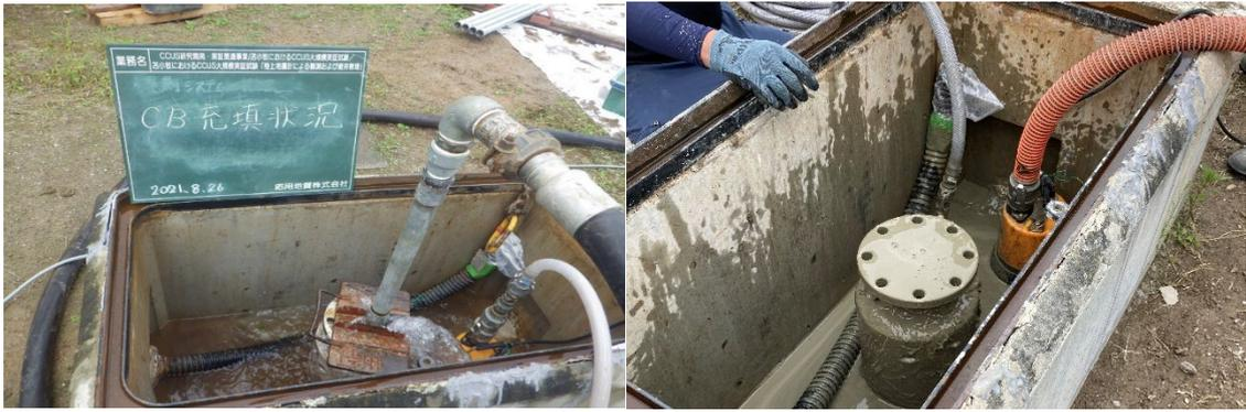
図 4.2-27 セメントミルク充填作業
