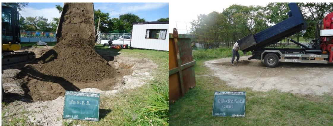
図 4.2-31 良質土による埋め戻し作業
