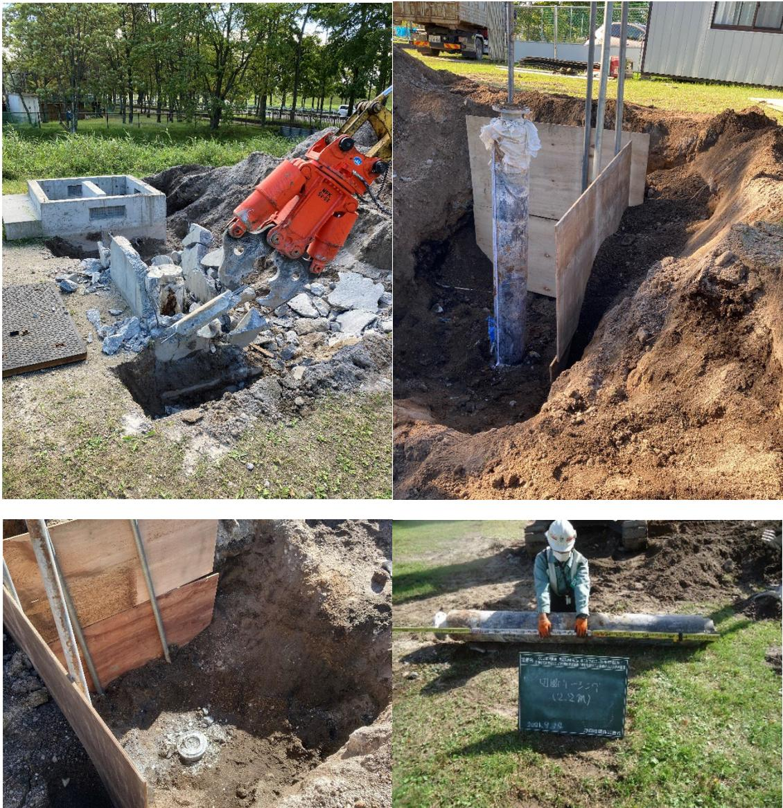
図 4.2-28 ケーシング切断作業
