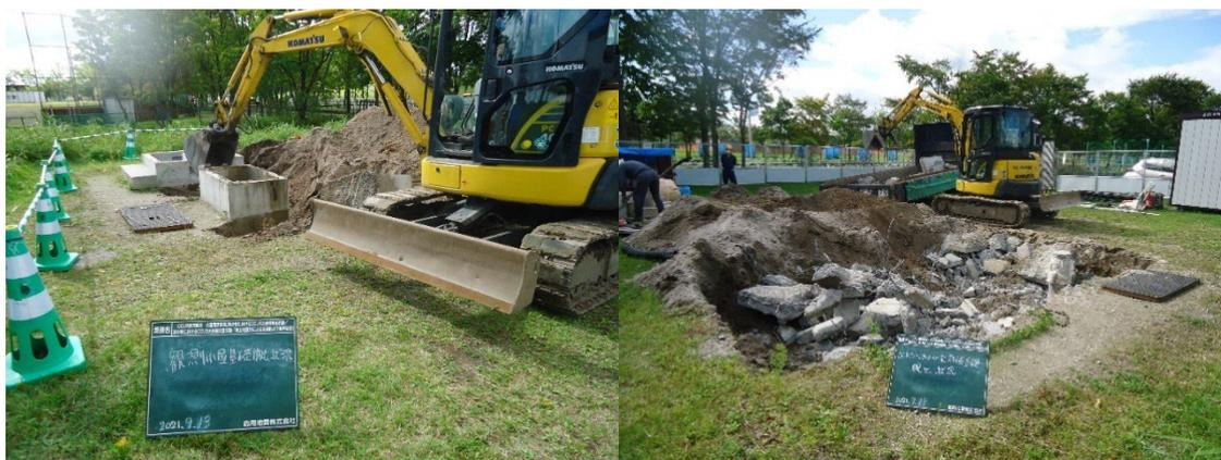
図 4.2-25 埋め戻しおよび整地作業
