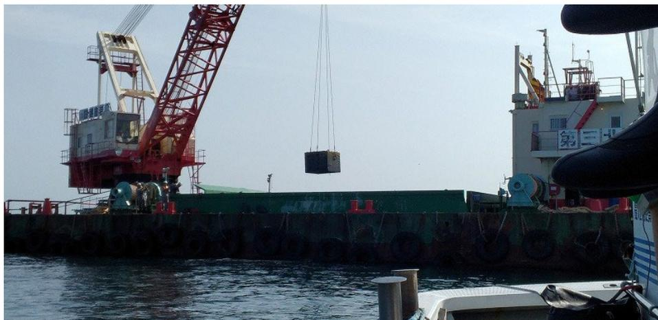
図 4.4-17 起重機船による OBS 設置容器吊り上げ作業
