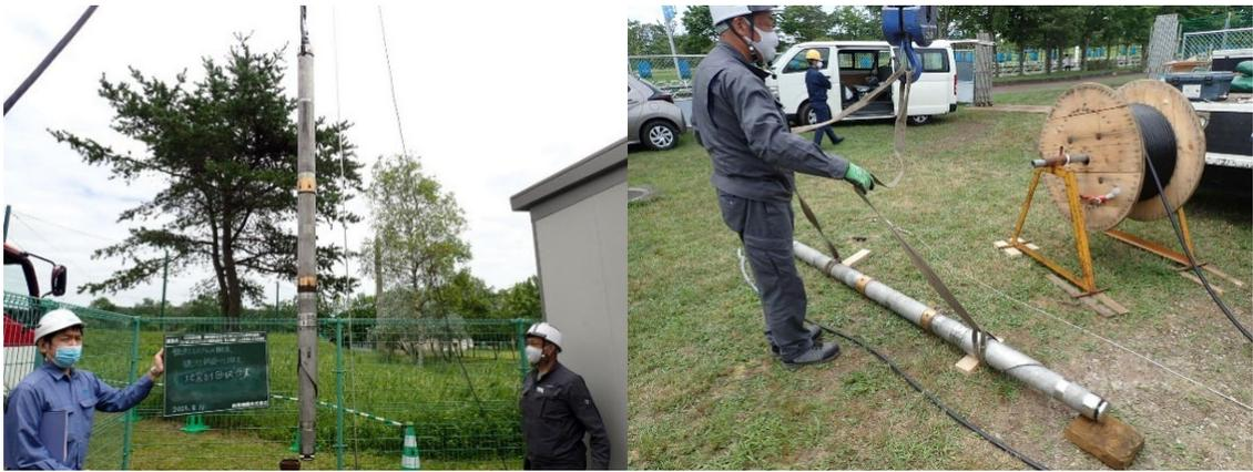
図 4.2-20 孔内地震計引き下ろし作業
