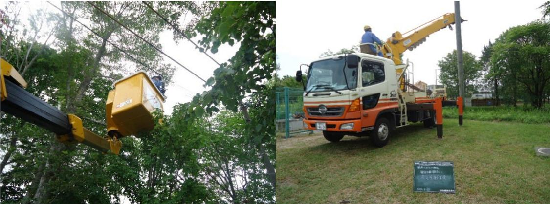
図 4.2-22 引込柱および架空線の撤去作業
