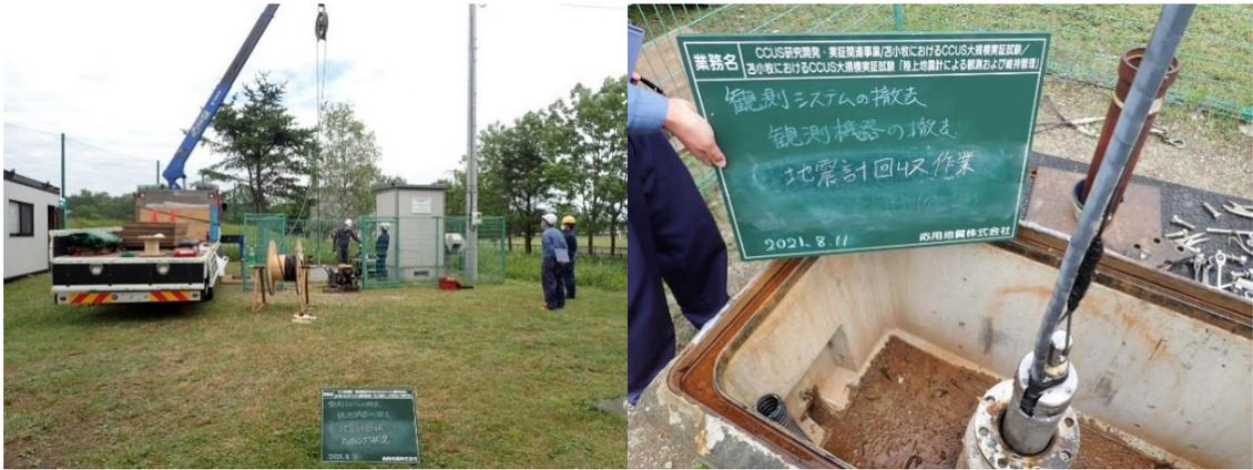
図 4.2-19 孔内地震計回収作業
