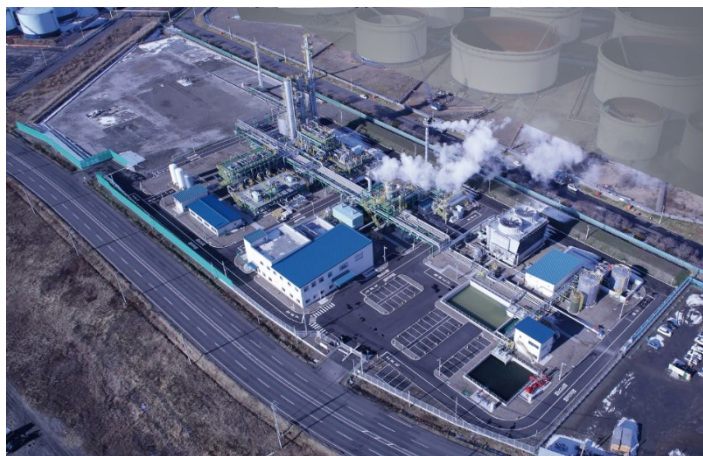
苫小牧CCS実証試験センター
