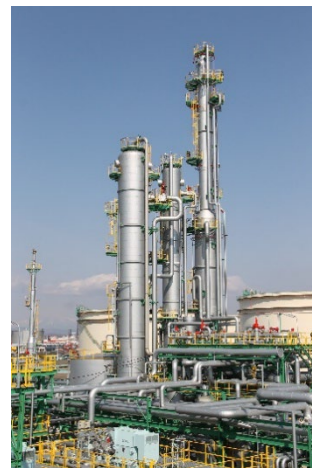
分離・回収設備
