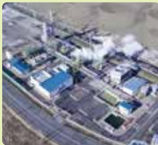
苫小牧 CCS 実証試験センター
