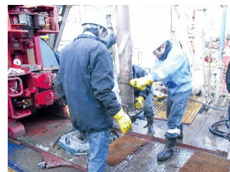
調査井掘削の様子
