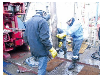
調査井掘削の様子
