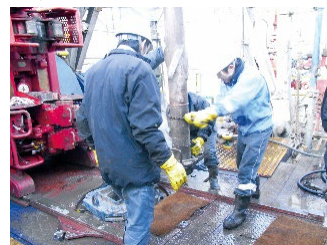
調査井掘削の様子
