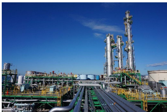
苫小牧CCS実証試験センター
