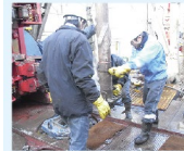
調査井掘削の様子
