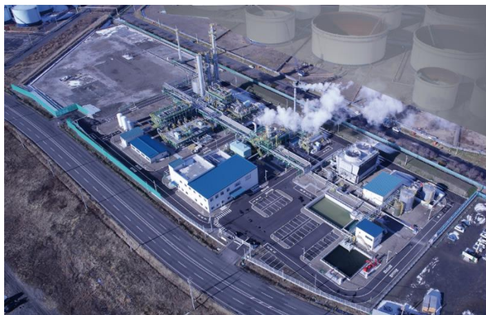
苫小牧CCS実証試験センター
