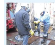
調査井掘削の様子
