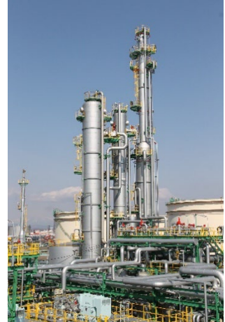
分離・回収設備
