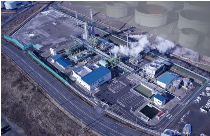
苫小牧CCS実証試験センター
