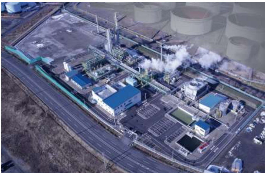
苫小牧CCS実証試験センター
