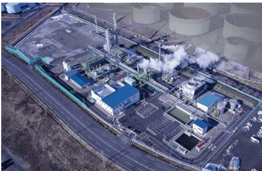
苫小牧CCS実証試験センター
