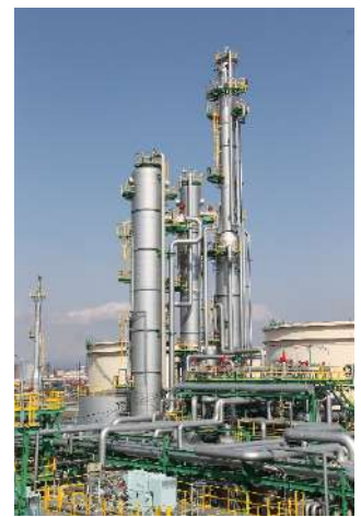
分離・回収設備
