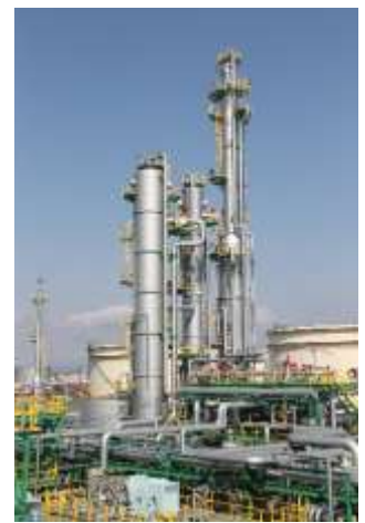
分離・回収設備
