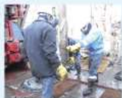
調査井掘削の様子
