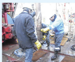
調査井掘削の様子
