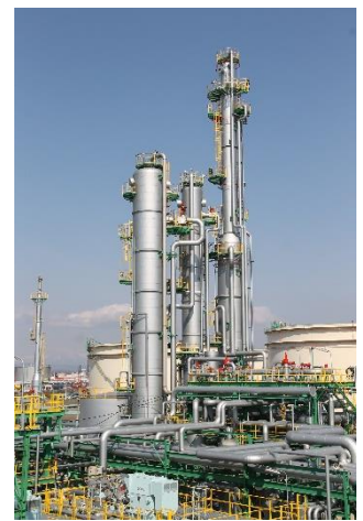
分離・回収設備
