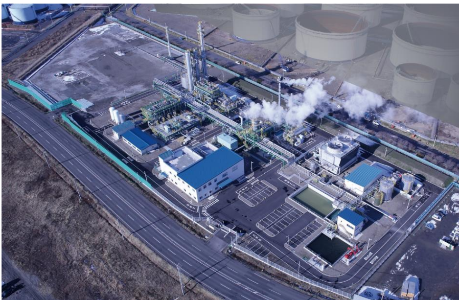
苫小牧CCS実証試験センター
