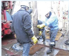
調査井掘削の様子
