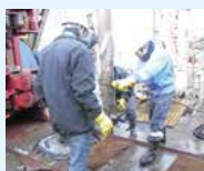
調査井掘削の様子
