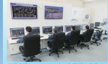
分散制御システムにより各設備を制御し、運転状況や異常を監視
