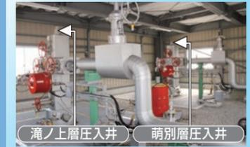
バルブ、圧力計等で構成されたCO<sub>2</sub>の流れを制御する装置
