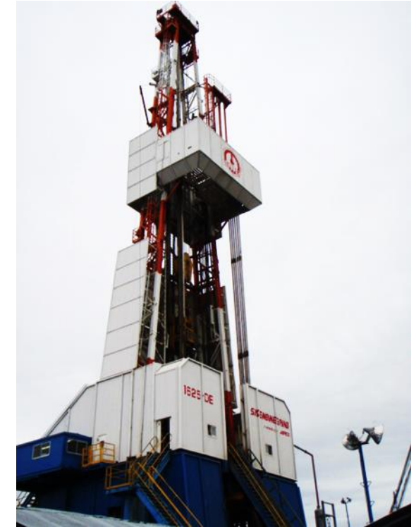
掘削装置(高さ60m)
