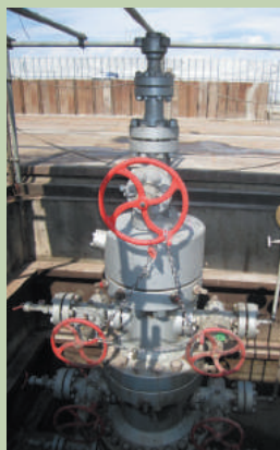
CCS-1の坑口装置
