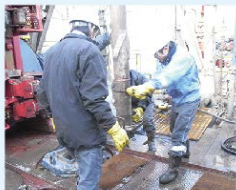
調査井掘削の様子
