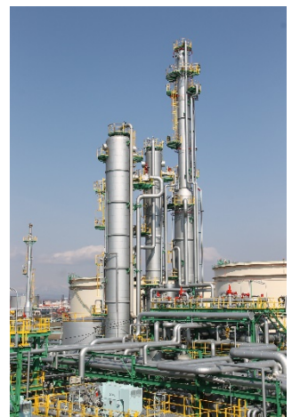
分離・回収設備
