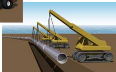
パイプライン敷設方法
